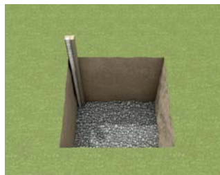
Rys. 1-2 Ułożenie cienkiej warstwy żwiru
